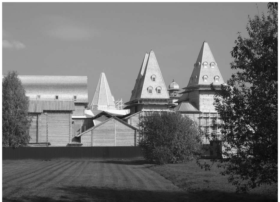
Современный строящийся дворец в Коломенском
